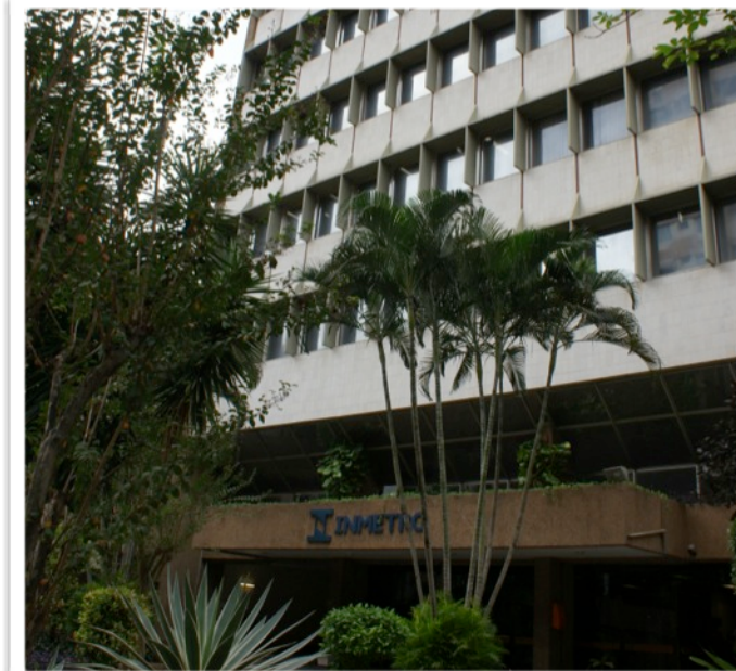
Sede Administrativa Rio Comprido
